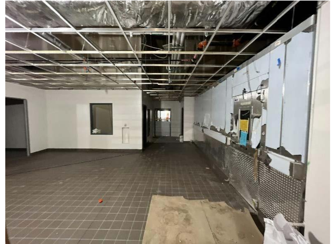
Inodoro grupal: cierre del techo, instalación de accesorios de plomería
