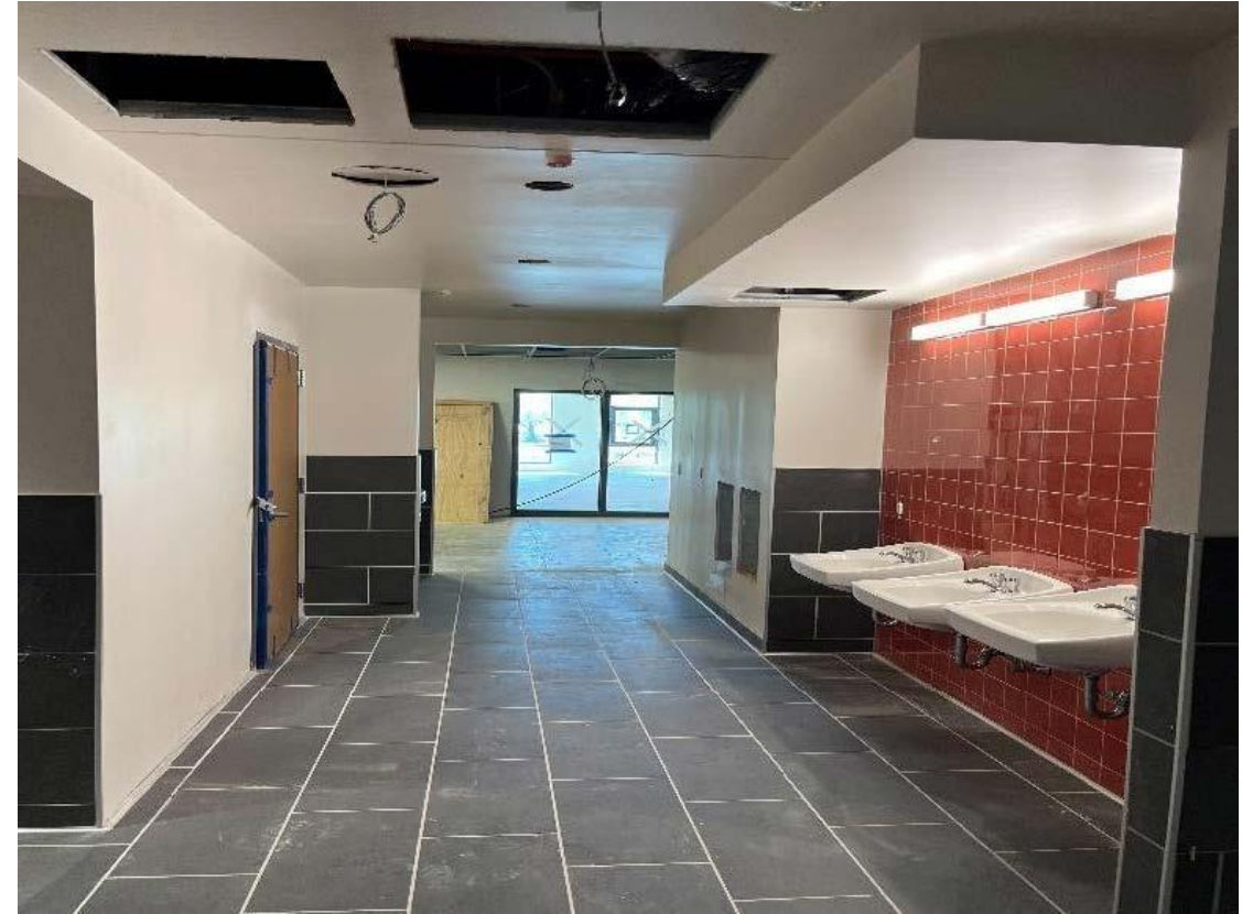
Inodoro grupal: baldosas de cerámica, instalación de VCT
