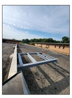
Légendes des photos de gauche à droite : Équipements mécaniques nouvellement installés sur de nouveaux socles en béton et images des nouveaux calages en acier du toit pour l'installation des RTU.
