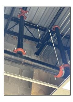
Légendes des photos De gauche à droite :[Images de l'ajout de la nouvelle conduite d'eau de Woodyard Road à la salle mécanique James Madison] Nouvelle conduite d'eau de 6", nouvelle bouche d'incendie associée à la conduite d'eau, image de l'installation de la voûte, pompe à incendie de la salle mécanique pour le système de gicleurs, et conduites de dérivation du système de gicleurs
