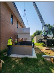
Légendes des photos de gauche à droite : Installation d'une nouvelle centrale de traitement d'air sur une nouvelle dalle de béton, pose d'un nouveau réseau de gicleurs et d'une nouvelle installation mécanique dans les couloirs, installation de nouveaux réseaux de gaines et de canalisations, et installation d'un nouvel équipement mécanique.
