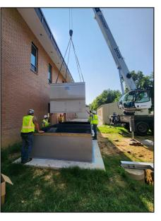
Descripción de fotos de izquierda a derecha: Instalación de la nueva unidad de manejo de aire (AHU, por su sigla en inglés) en una nueva plataforma de hormigón, instalación preliminar y mecánica de la nueva línea de rociadores a través de pasillos, conductos y líneas troncales recién instalados. Imagen del traslado del equipo mecánico recién instalado.
