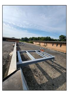
Descripción de fotos de izquierda a derecha: equipo mecánico recién instalado en las nuevas plataformas de concreto e imágenes de los nuevos estribos de acero para techos para instalación de RTU.
